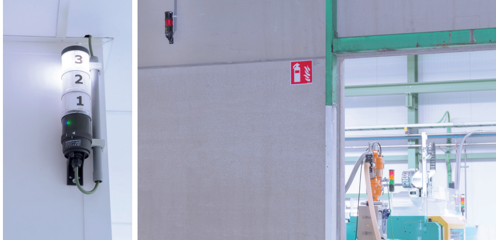
Foto 1: Een signaallamp in de kantine geeft aan of en waar ergens in de productiehallen er zich een machinestoring voordoet.
