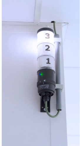
Bild links: Eine zusätzliche Signalleuchte in der Kantine zeigt an, ob und wenn ja in welchem Bereich der Produktionshallen eine Maschinenstörung vorliegt (Head-of-Line-Funktion).
